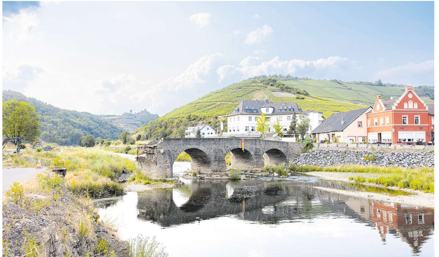
In Rech, dem Nachbarort von Dernau, wurde die historische Nepomukbrücke 2021 zerstört. Sie soll an anderer Stelle neugebaut werden.
