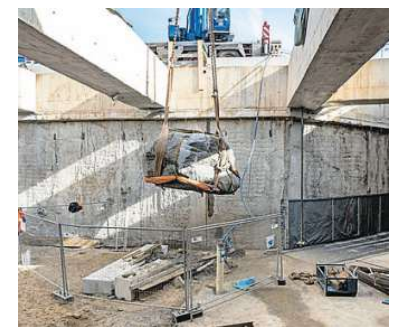
Der Findling tauchte bei Bauarbeiten für Hamburgs neue U-Bahn auf.
