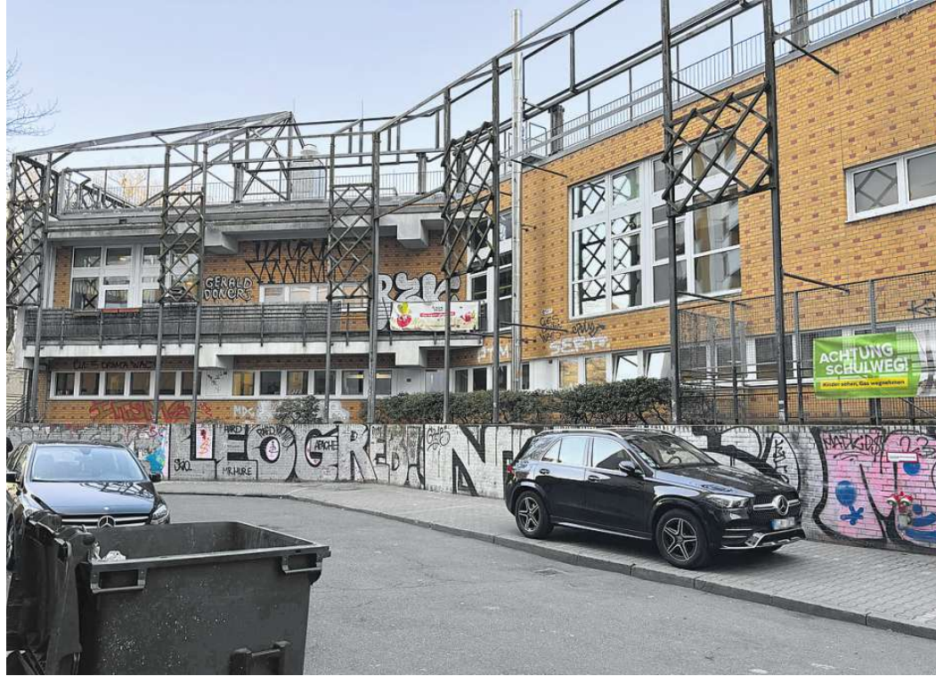
Das Gebäude am Kottbuser Tor wurde von einem Parkhaus zu einer Kita umfunktioniert.
